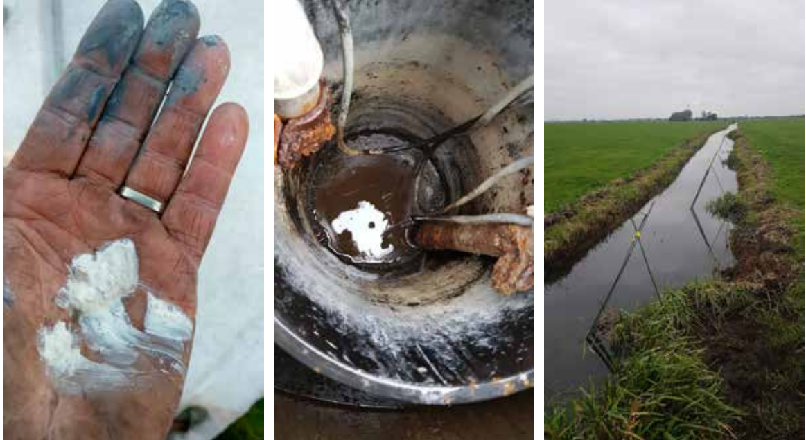
Zwavelproblematiek bij gebruik van drukdrainage. Op moment van draineren worden wordt elementair zwavel afgezet als witte vaste stof in de pompput en drains. Dit zorgt voor verstoppingen en aantasting van het drukdrainsysteem.
