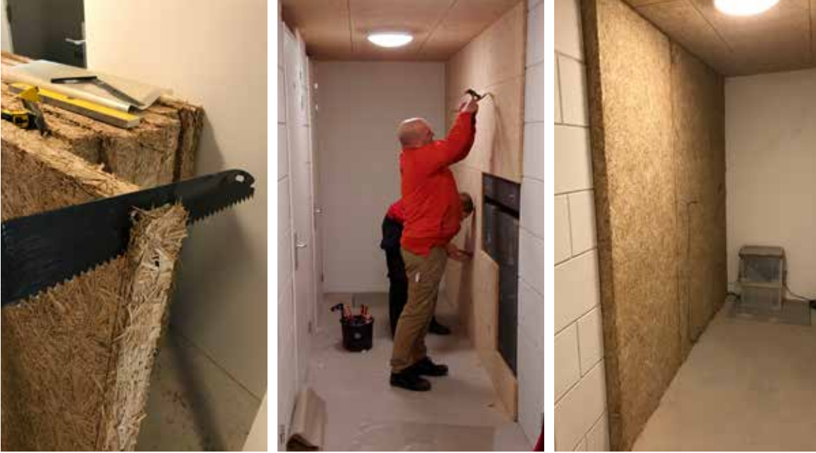
Bouwbedrijf Van Wijnen plaatst van lisdodde gemaakte isolatieplaten.
