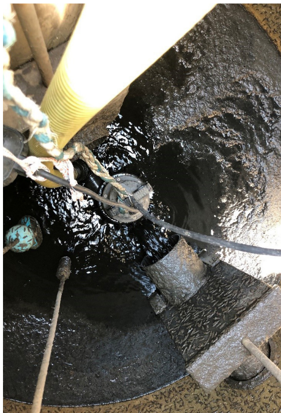
Figuur 4 Pompput vol met bagger na schoonspuiten drains
