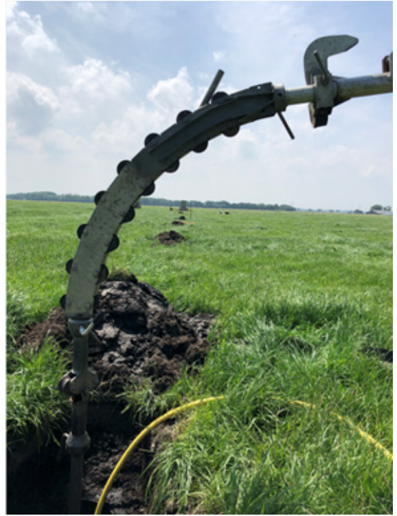
Figuur 5 Doorspuiten van de hoofddrain
