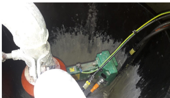
Figuur 3 Aantasting van instrumenten en pompput
