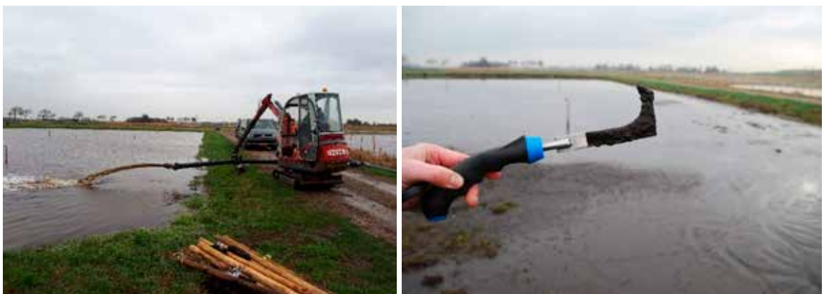
Figuur 3.9: Beeld van het inspuiten van de baggerspecie uit De Braak (maart 2019).
