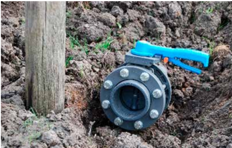
Figuur 3.5.: Elk teeltvak heeft één handmatig te regelen inlaat en een uitlaat in de vorm van een slibkist (rechts foto is nog zonder balkjes om het peil te sturen).
