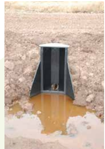
Figuur 3.5.: Elk teeltvak heeft één handmatig te regelen inlaat en een uitlaat in de vorm van een slibkist (rechts foto is nog zonder balkjes om het peil te sturen).
