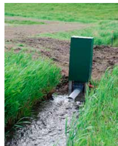
Figuur 3.2.: Sloot langs de provinciale weg met het bestaande polderpeil. Rechts één van drie automatische inlaten als inlaat van een regelsloot.
