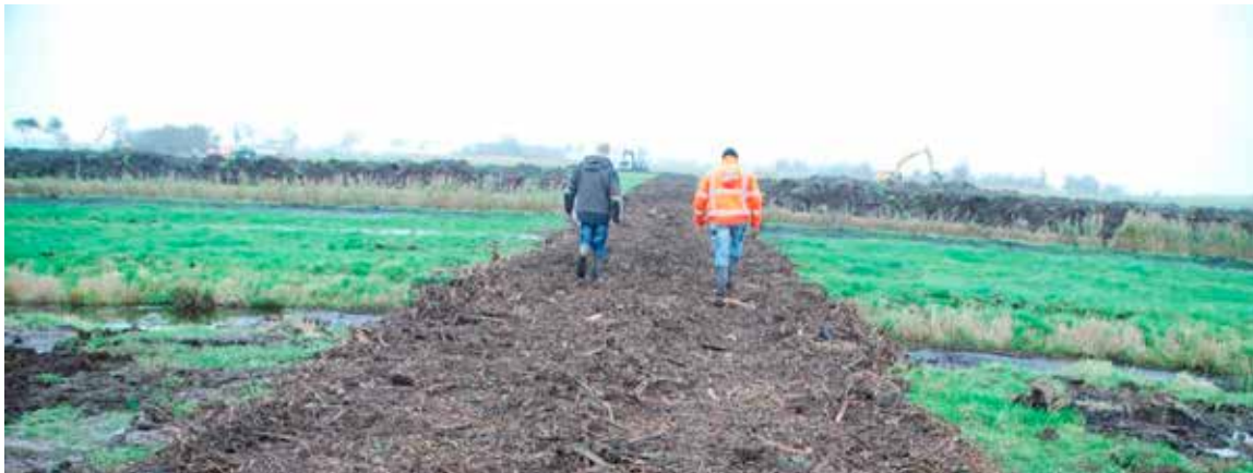
Figuur 3.7.: Er zijn enkele tonnen houtsnippermateriaal aangebracht als fundament van het gravelpad.
