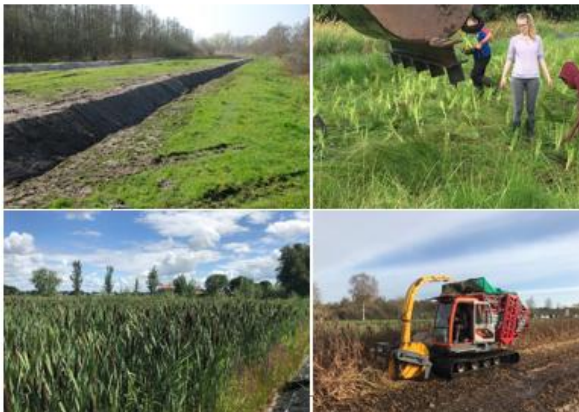
Figuur 8. Linksonder: Vak 5 (na aanleg van dijkjes, voor de inplant). Linksonder: Lisdoddeveld in het eerste jaar.
