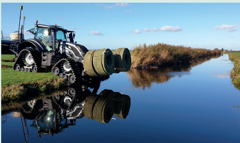
Foto: aanleg onderwaterdrainage
