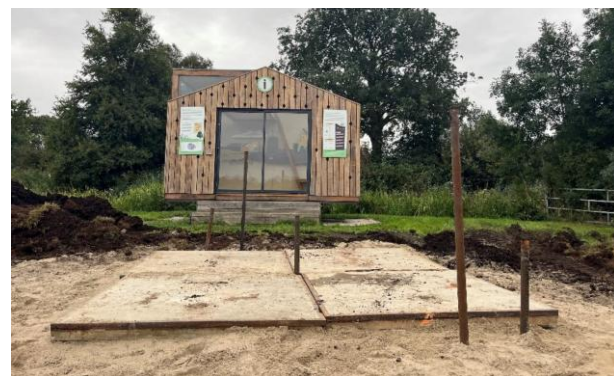
Afb. 6/7/8 aanleg proefveld voor fundatieproef met wilgentenen in Zegveld
