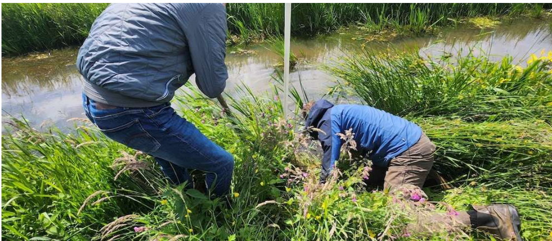
De sloot en oever moeten bij de eindbuizen goed worden schoongehouden om te voorkomen dat de eindbuis vervuild of verstopt raakt. Het terugvinden van de eindbuizen kost soms even tijd.
