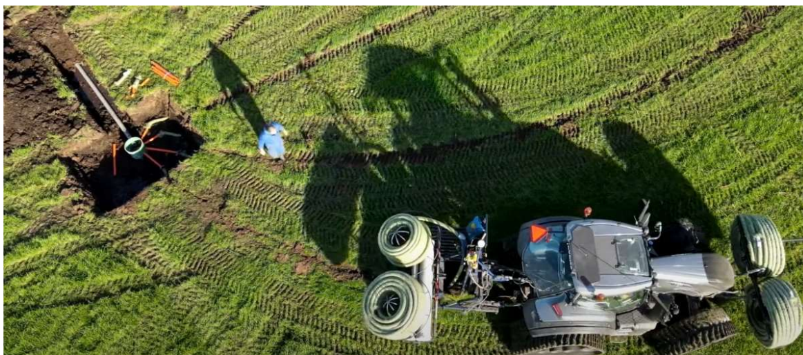
Aanleg WIS met links op de foto een verdeel-/tussen-/doorspoelput
