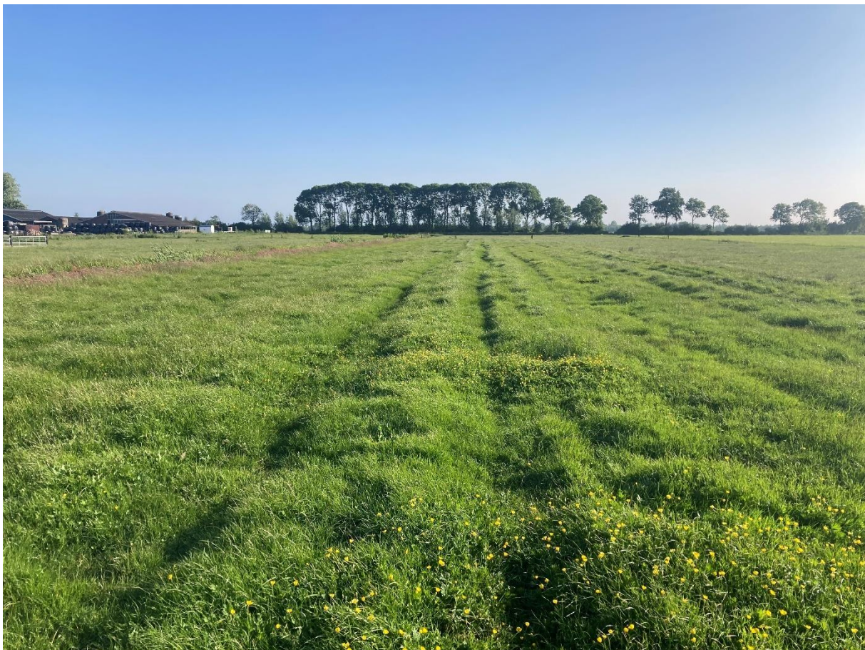
Figuur 3: Rijschade als gevolg van de aanleg van extra drainagebuizen.
